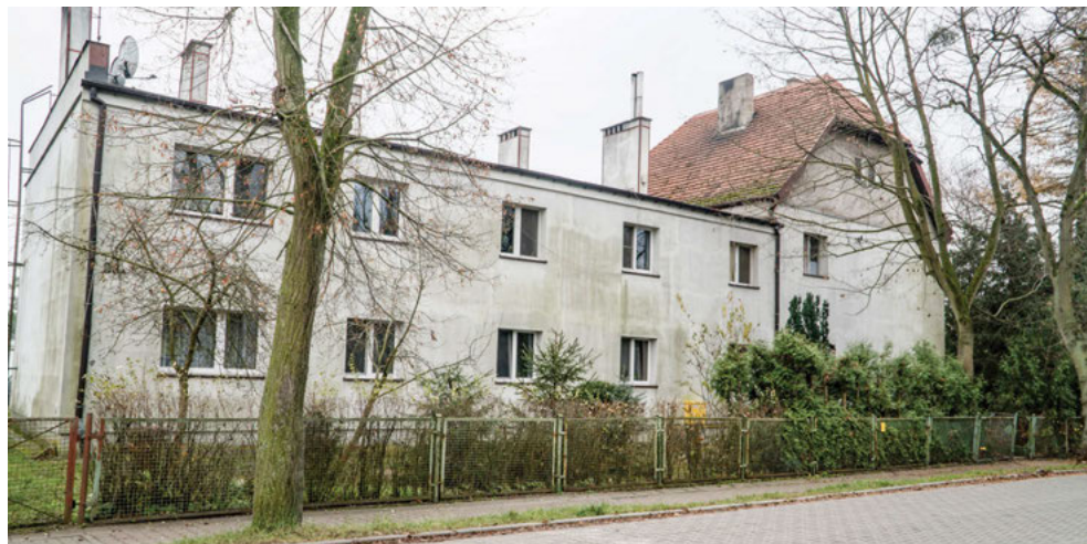
Budynek dawnej szkoły w Bolechowie, stan aktualny. Fot. Małgorzata Kubska.
