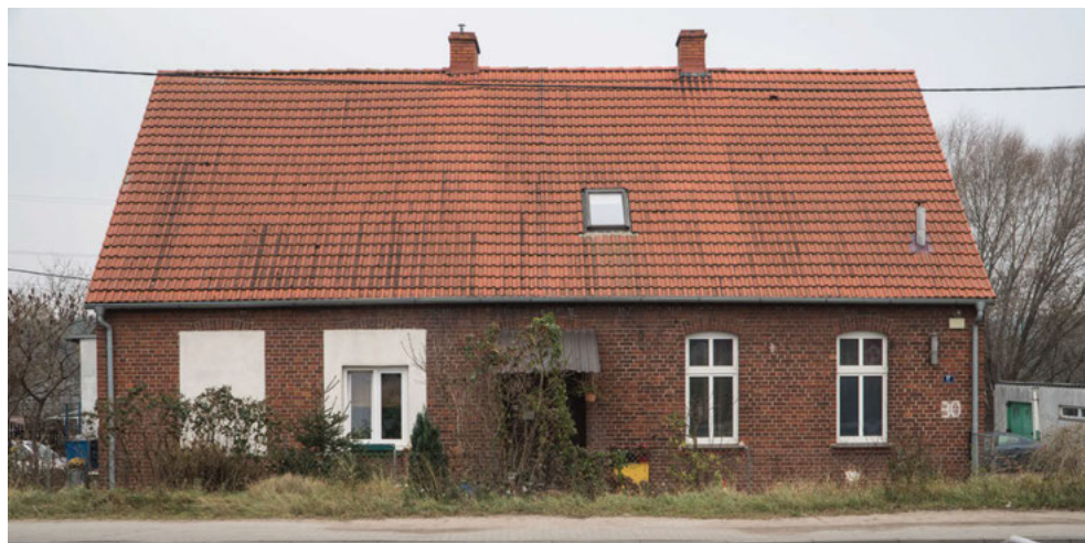
Budynek dawnej szkoły w Koziegłowach, stan aktualny. Fot. Małgorzata Kubska.
