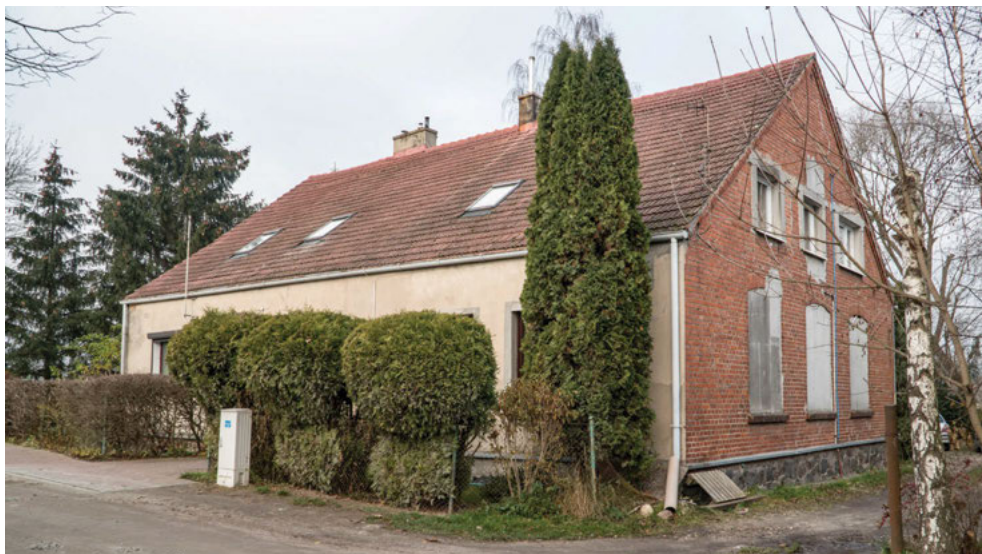
Budynek dawnej szkoły w Kicinie, stan aktualny. Fot. Małgorzata Kubska
