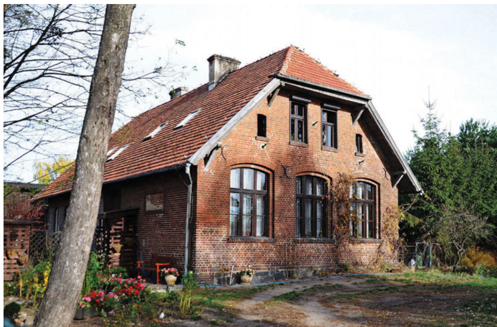
Budynek szkoły w Promnicach z 1905 roku, stan aktualny. Fot. Małgorzata Kubska.
