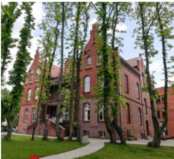
Fasada starego budynku - widok z ogrodu. Źródło: Oddział Opiekuńczo-Lecniczy w Owińskach.
