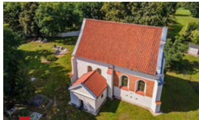
W 2020 roku zakończono główne prace konserwatorskie we wnętrzu i na zewnątrz kościoła pw. św. Mikołaja. Inwestycję przeprowadzono dzięki wsparciu powiatu poznańskiego. Fot. Marcin Deckert.
