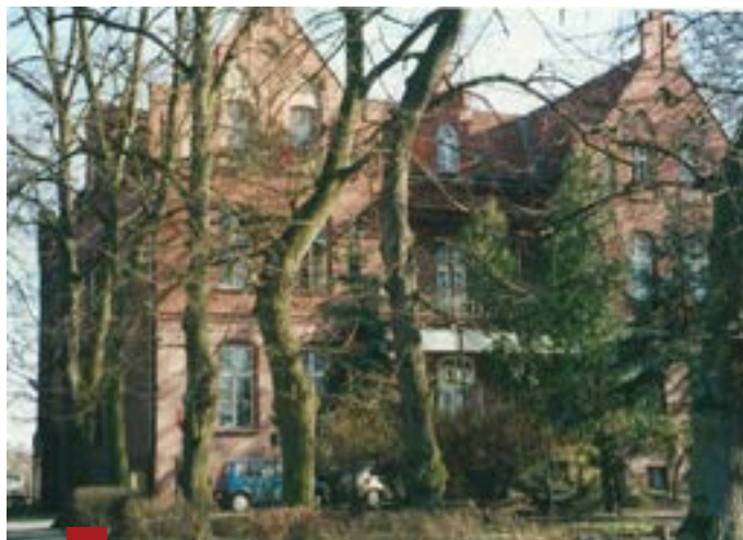
Budynek dawnego domu starców, dziś siedziba Zakładu Opiekuńczo-Leczniczego. Fot. Danka Pawlicka.
