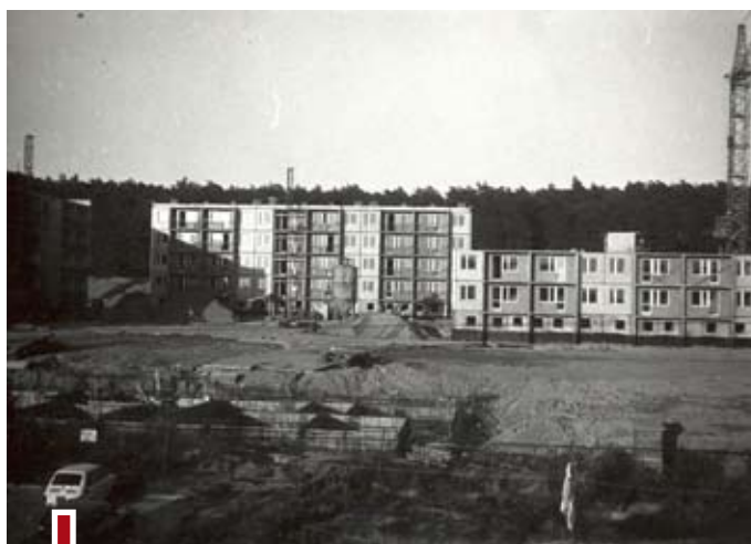
Budowa osiedla 40-lecia PRL, lata 1984-86
