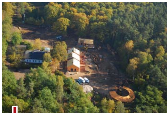
Budowa Centrum Edukacji Turystycznej pod Dziewiczą Górą, rok 2012
