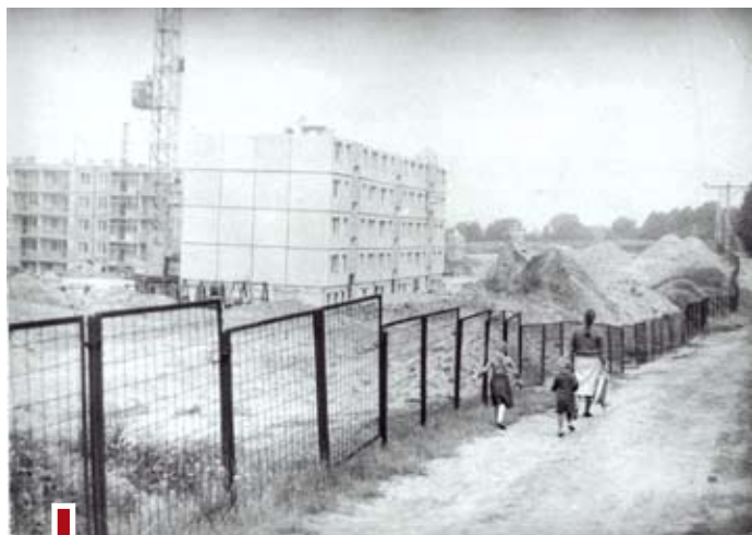
Budowa osiedla 40-lecia PRL, lata 1984-86
