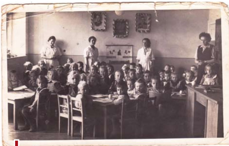
9. Przedszkole w budynku po domu ubogich przy placu Zielonym w Miękówku, rok 1952
